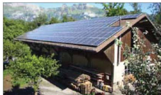
Werkhof in Bendern FL mit 49 kW.
